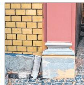
Markus Günther, Ralf Hofmann, Bernhard Möbs und Hans Berthold (v.l.) freuen sich, dass die Arbeiten in der Wilhelmstraße 2 bald abgeschlossen sind. Der Sockel (unten rechts) war vorher stark beschädigt, er wird mit Schaumglas nachgebildet. (Fotos: ihm)
